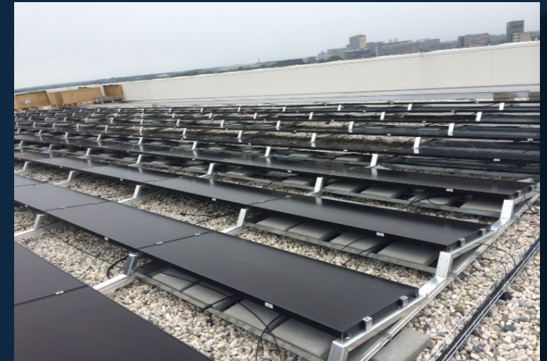
Vervanging door moderne panelen 2024
