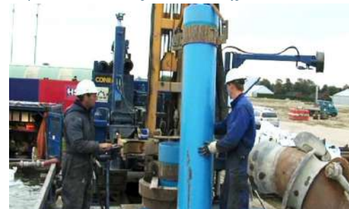
Impressie van een boring. Inbouwen stijgbuis
