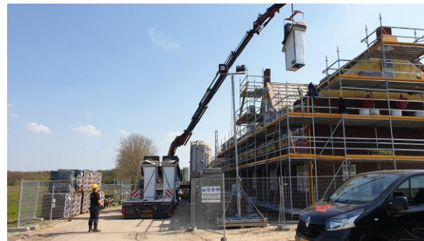
Prefab installatie van warmtepompen
